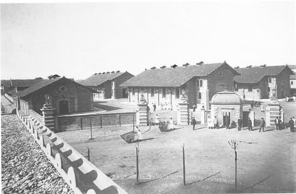
Bauten im Innern der Anlage
