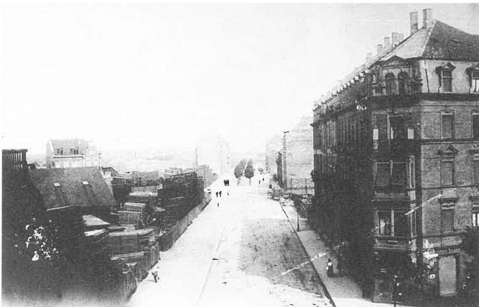
Blick in die Gerwigstraße Richtung Osten um 1899.
