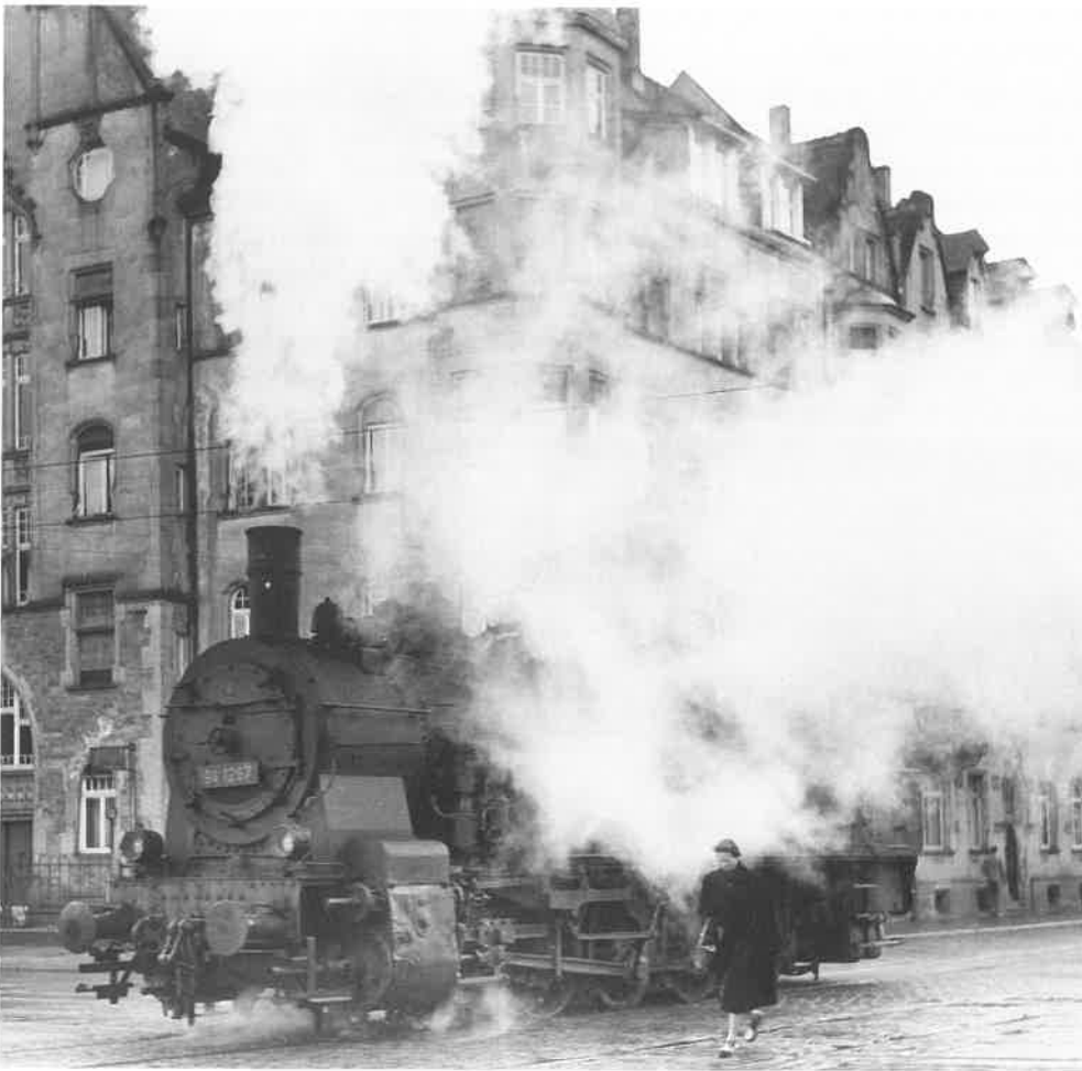
Das „Bimmelbähnchen“ der Bundesbahn an der Kreuzung Gerwig-/Tullastraße, um die Industriebetriebe direkt zu beliefern.
