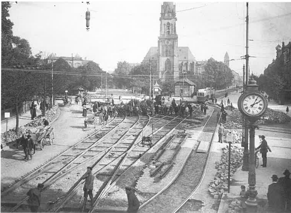
Gleisbauarbeiten am Durlacher Tor Oktober 1919
